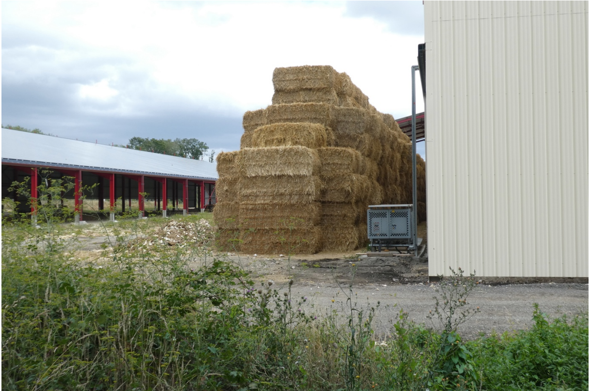
Stockage au nord du bâtiment 2 à proximité de l'onduleur Cliché du 26 juillet 2023
